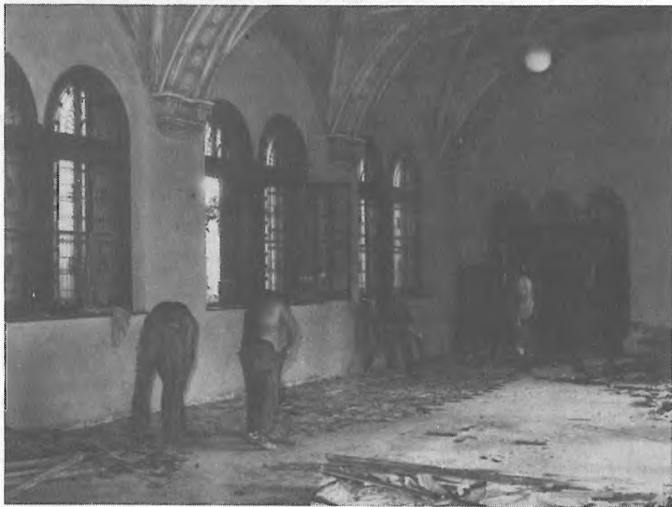
11. sz. fotó: Nagy ütemben folyik a Múzeum belső felújítási munkája
